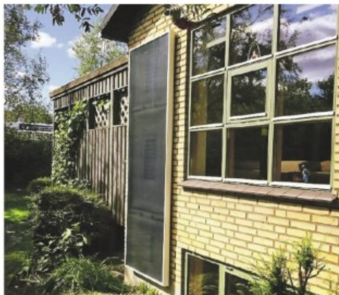
Anlægget er et ventilationssystem, der udnytter solens indstråling i dagtimerne. Pressefoto
