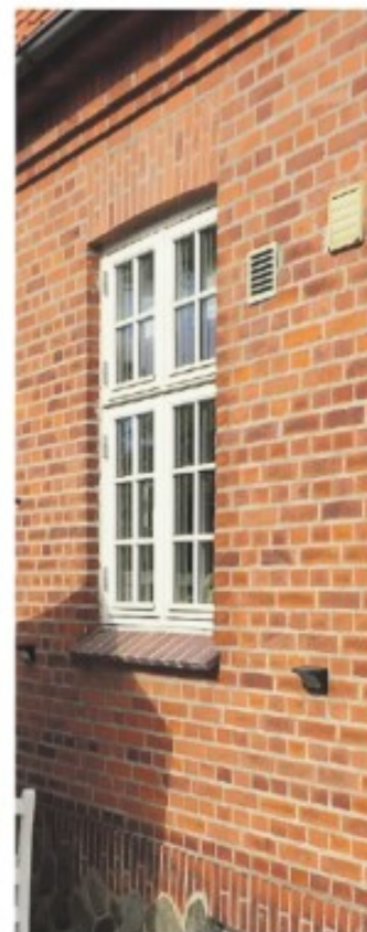
Udover et væsentligt forbedret indeklima er anlægget også billigt både i drift og i anskaffelse. Det er et 12 Volt anlæg der kobles til elnettet via en lille transformator og koster derfor under ca. 100 kr. om året i drift. Filteret er selvrensende og holder 10-15 år.
