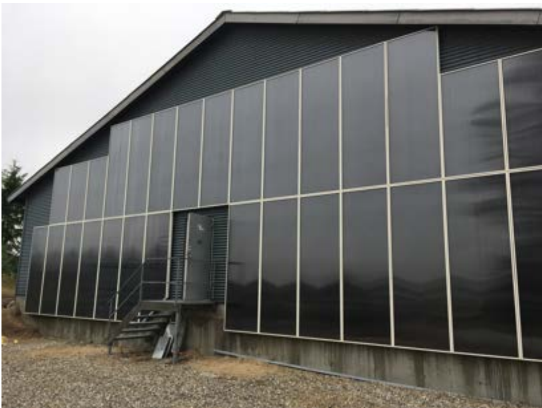
Billede: 96 m 2 anlæg til lagerhal på 3.500 m 2
