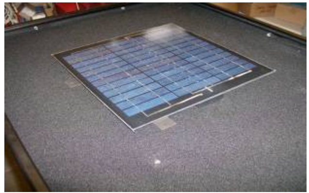
11. Den indbyggede solcelle udskiftes med en ny solcelle.
