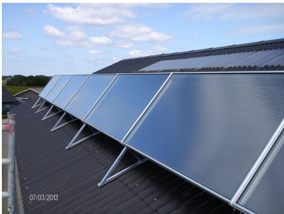
Den Jyske Håndværkerskole Hadsten
