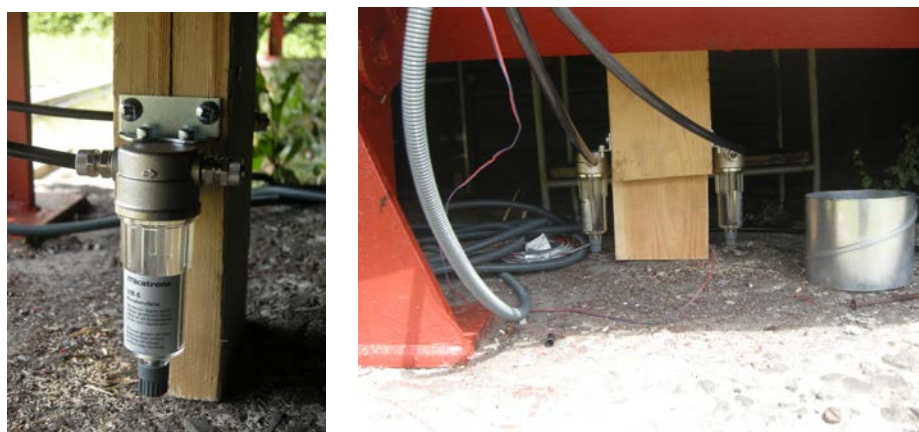
Figur 11. Kondensfælde/kondensopsamler
