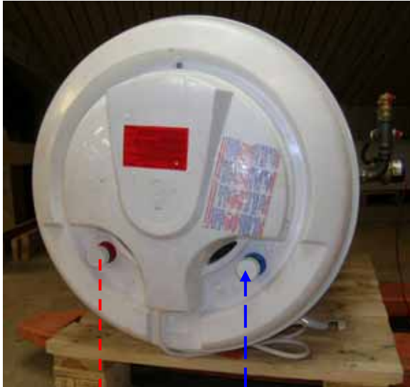
TWW-Speicher Unterseite Vorerwärmtes Wasser Austritt Kaltwassereintritt
